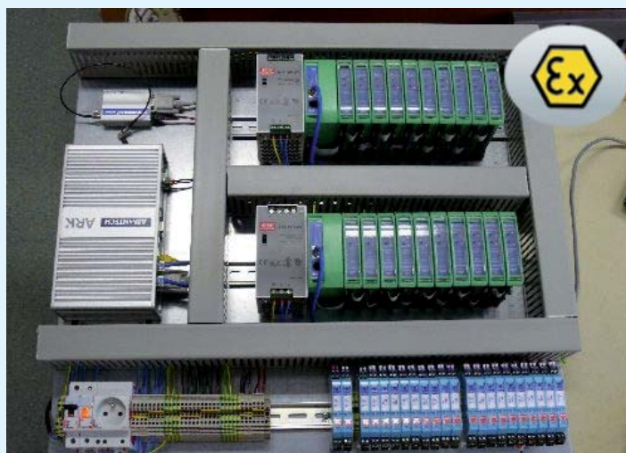
System monitoringu drgań kompresora i silnika elektrycznego na pokładzie maszynowym
